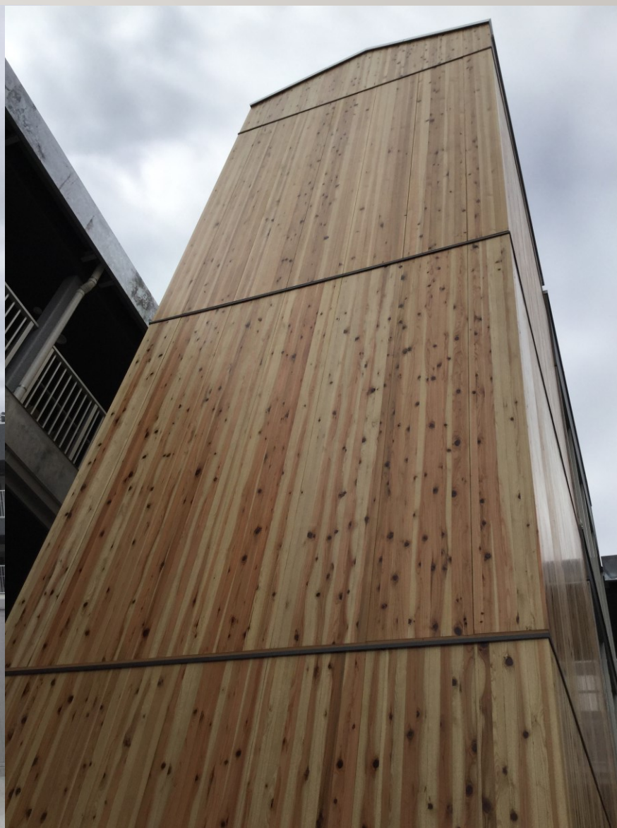
復興公営住宅 買取方式（中層）磐崎団地 CLT構造＋鉄骨造W.ALC
