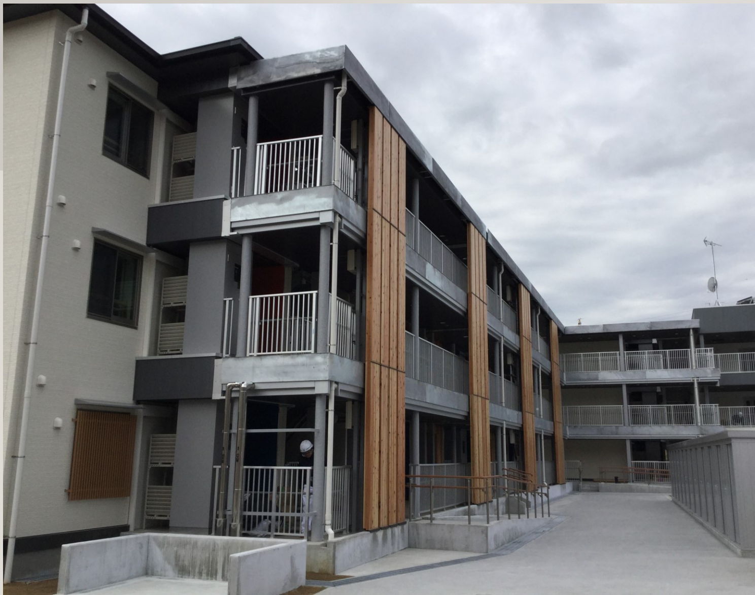
復興公営住宅 買取方式（中層）磐崎団地 CLT構造＋鉄骨造W.ALC
