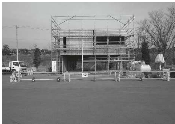
鉄骨造+W.ALC（壁）+CLT（壁）+JAS 集成材（床）を使用した実証実験棟
