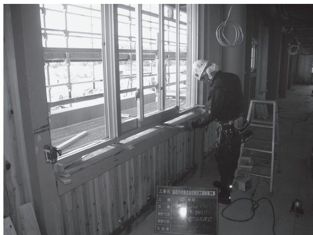
開口補強・サッシ取り付け
