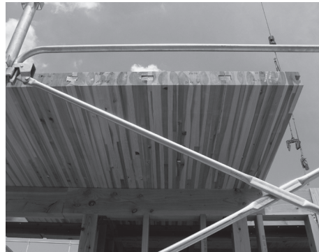
屋根下地施工中
