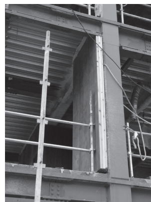
出隅基準パネル取り付け
