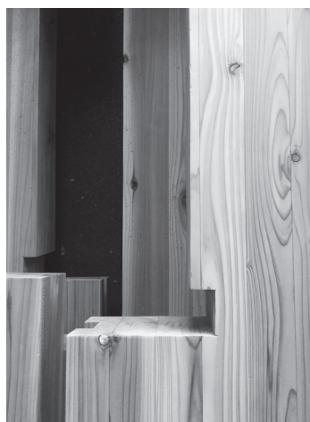
サッシ水切り部加工例
