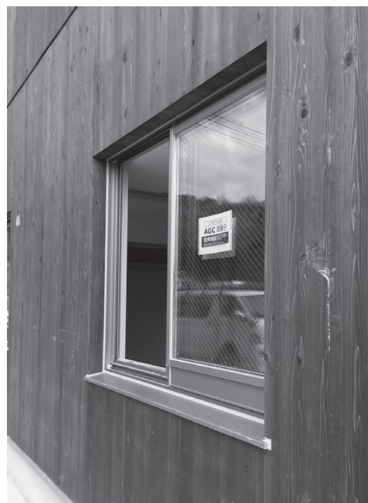
ALC 用サッシ納め参考（インセット納まり）
